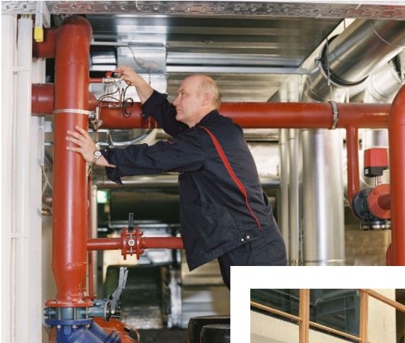
Mitarbeiter des technischen Dienstes bei Wartungsarbeiten an der Heizungsanlage (Berlin Ostbahnhof)
